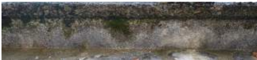
Fig. 108 – In basso: deposito superficiale e colatura, ala nord. (Fotografia dell'archivio personale, sopralluogo del 28/05/2021).
