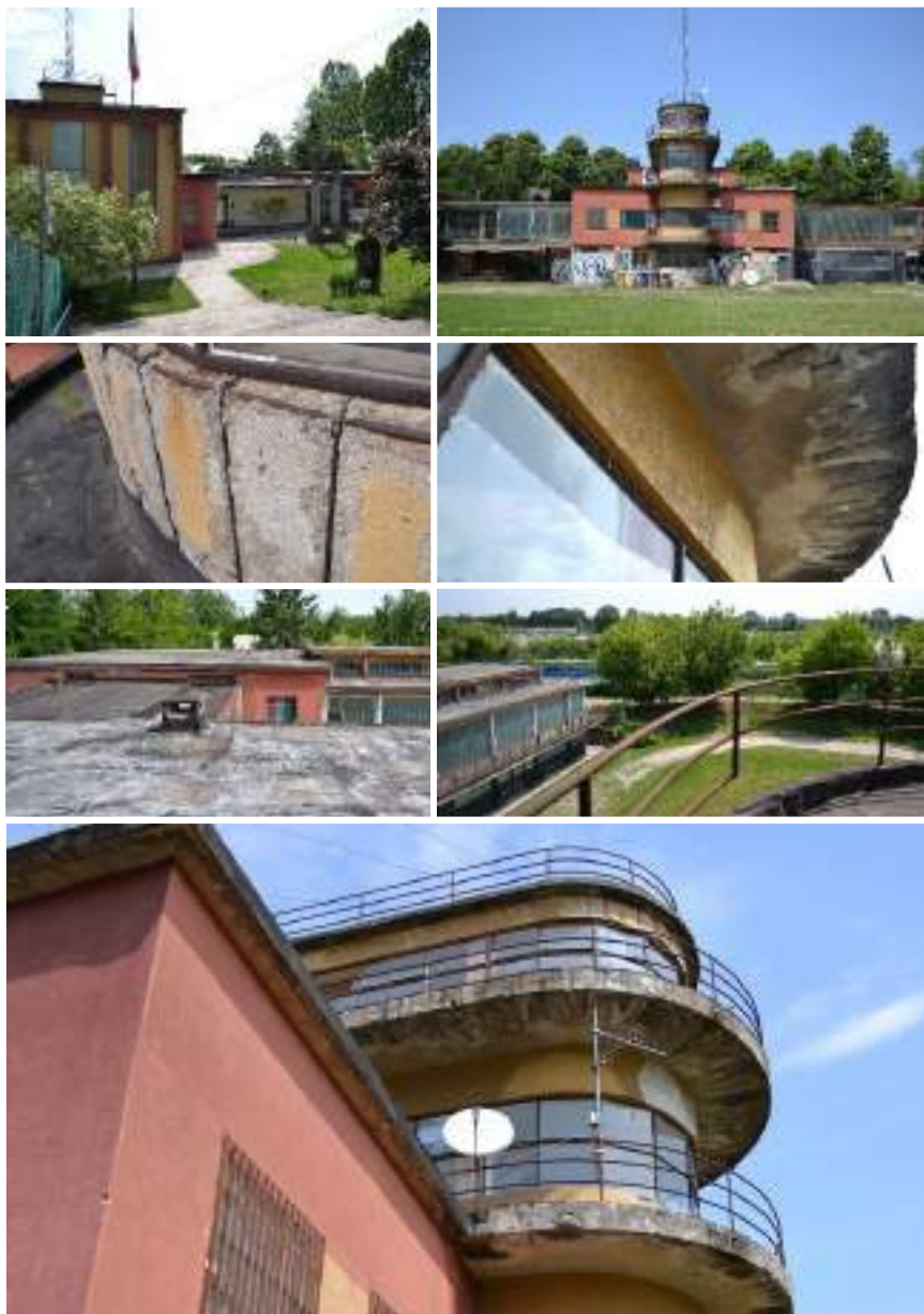
Fig. 125-126 – In mezzo: l'espulsione del copriferro (spalling) sugli elementi verticali ed orizzontali del volume a torretta del corpo centrale.
